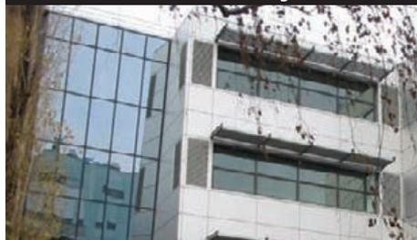
Ostakljeni okviri vješaju se na aluminijsku konstrukciju rastera i prekrivaju je s vanjske strane. Vanjska pasica aluminijskog profila od ostakljenog okvira je minimalno vidljiva.
