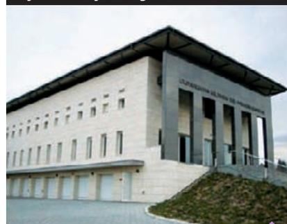
Objekt u Zagrebu (Mihaljevac) građen je u razdoblju od 2002. do 2003. godine. Cijela građevina izvedena je s ventiliranom kamenom fasadom.
